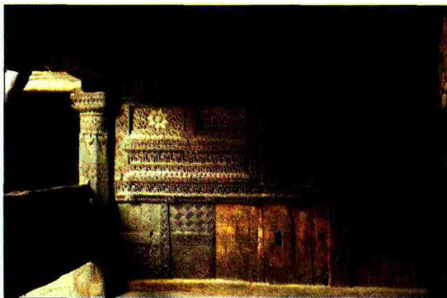
La casa di Toha a Korphè, con le pareti lignee del piano Balti realizzate con l'assemblaggio di pannelli intagliati recuperati da abitazioni demolite (© Dpa, Politecnico di Milano, 2006)
